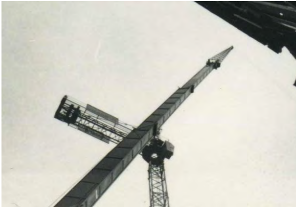
Der Gegenausleger ist montiert.
