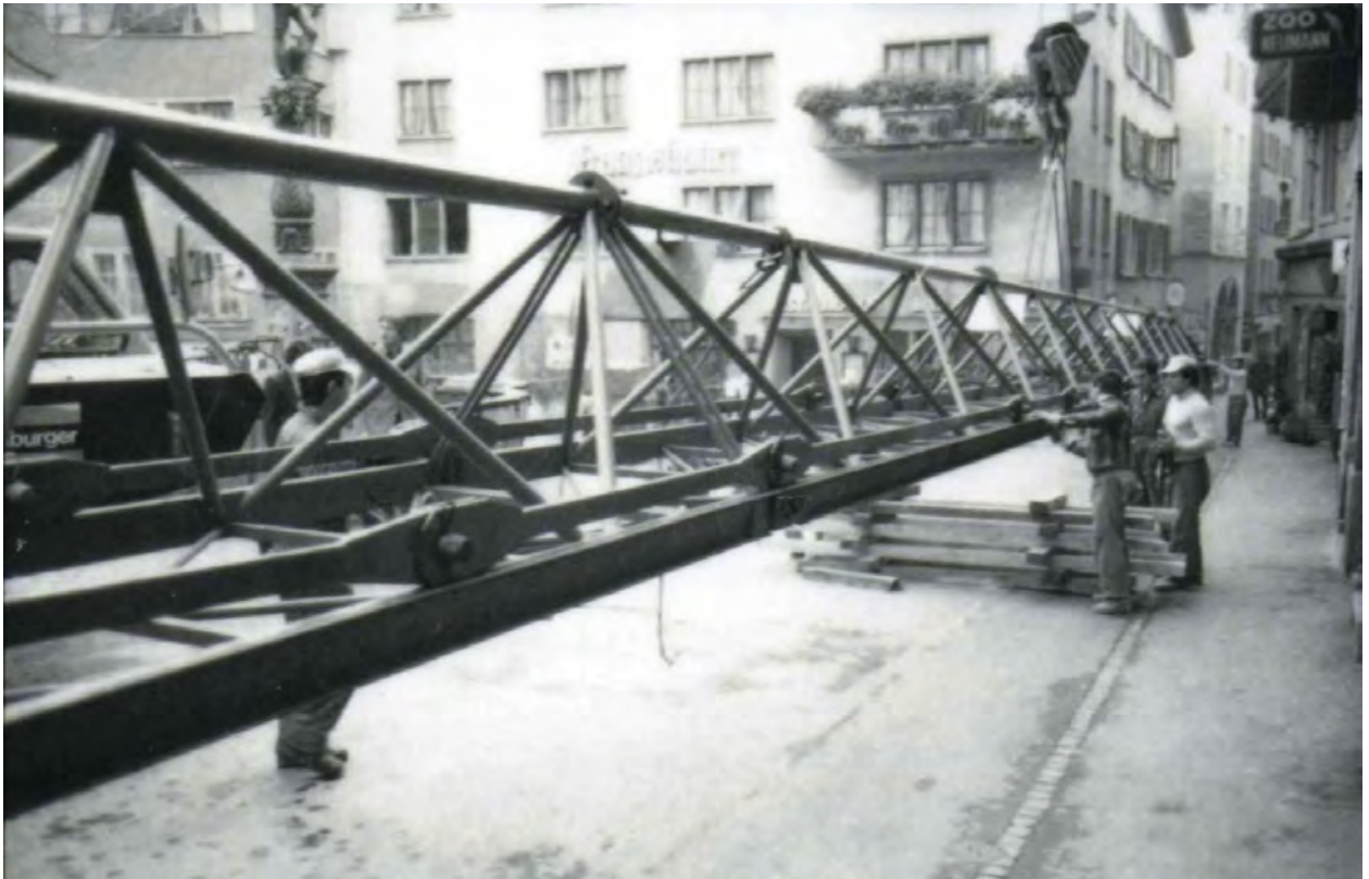
Der Ausleger ist bereit zur Montage. Das Aufziehen in der engen Gasse unter laufendem Passantenverkehr ist sehr schwierig.
