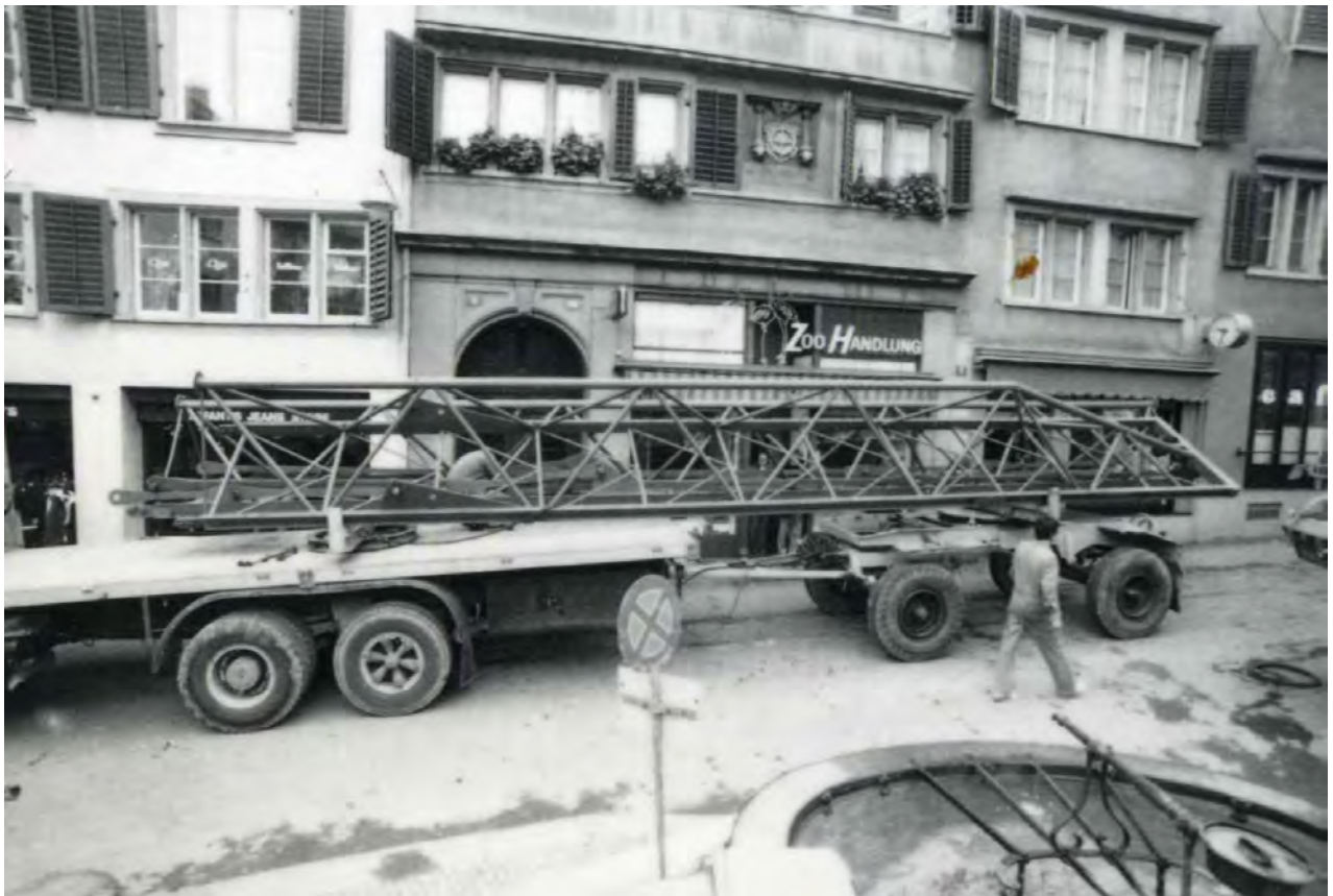
Anlieferung des Auslegers in kürzester Länge. Alle Transporte mussten rückwärts durch enge Gassen zur Montagestelle gelangen.
