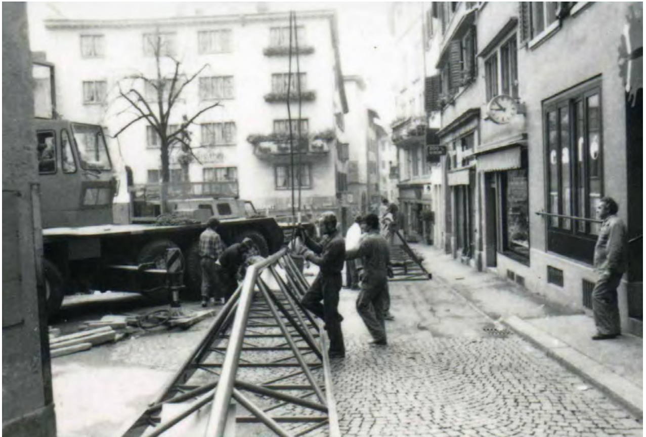
Zusammenbau des Auslegers auf dem abschüssigen Gelände.
