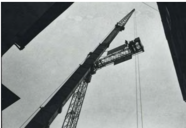
Der Gegenausleger ist montiert.
