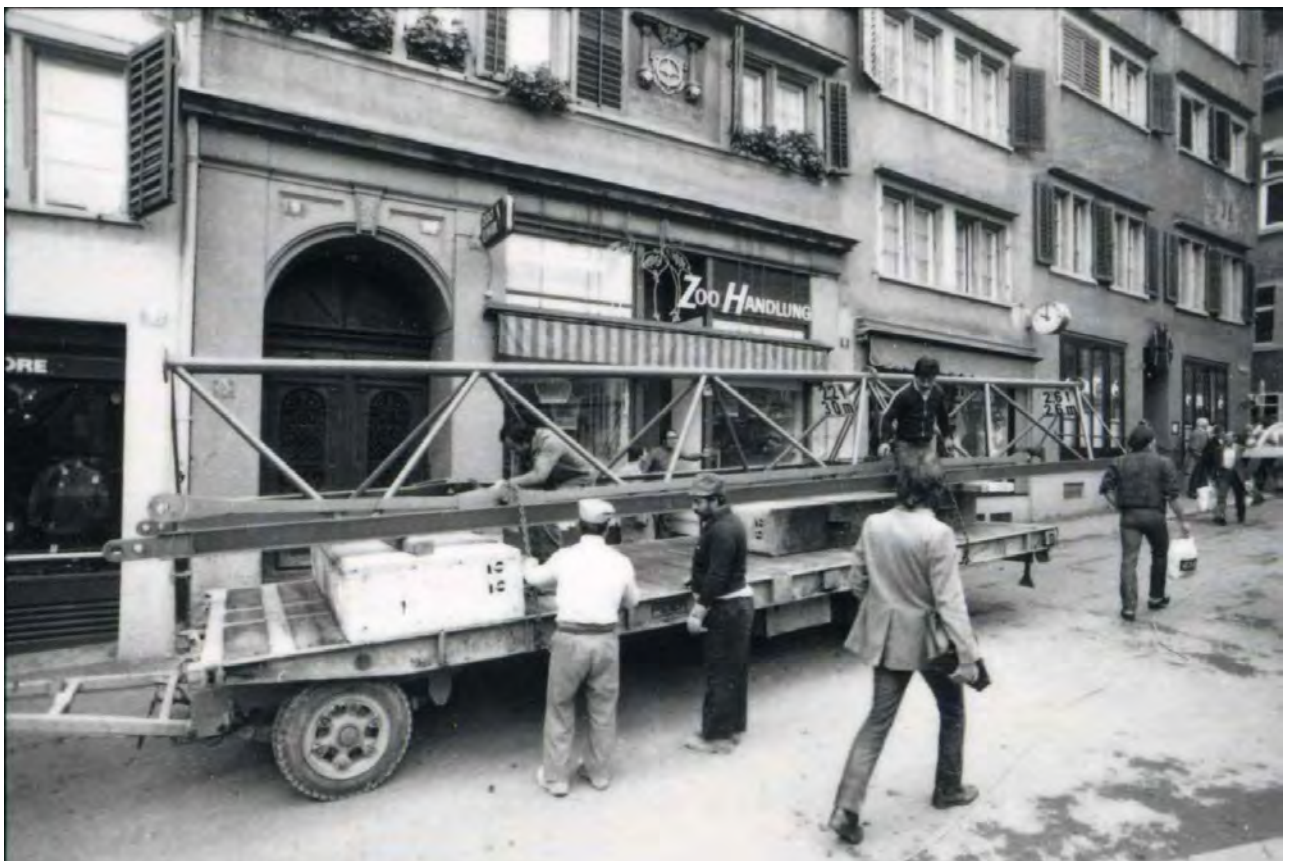
Anlieferung des Auslegers in kürzester Länge. Alle Transporte mussten rückwärts durch enge Gassen zur Montagestelle gelangen.
