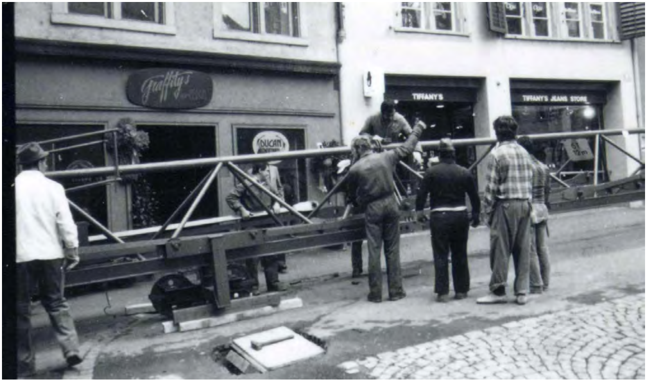
Das Auslegeranlenkstück mit der Laufkatze wird platziert.
