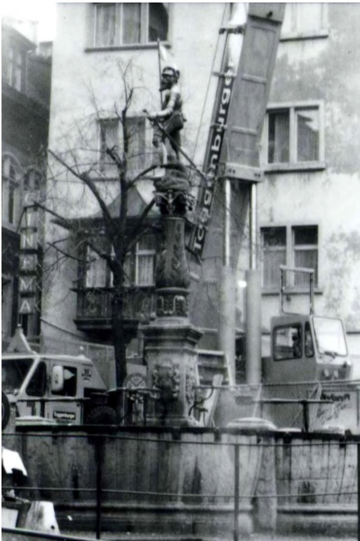
Der Ausleger ist bereit zur Montage. Das Aufziehen in der engen Gasse unter laufendem Passantenverkehr ist sehr schwierig.
