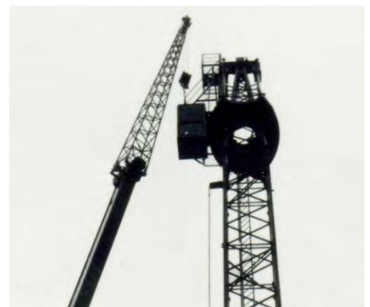
Anlieferung und Montage des Königs und der mit Rollendrehkranz. Montage der Kabine.
